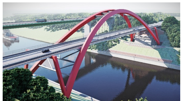
Vielvariante und Entwurfsplanung: Spreizbogenbrücke Stützweiten 34,8 - 178 - 34,8 m
