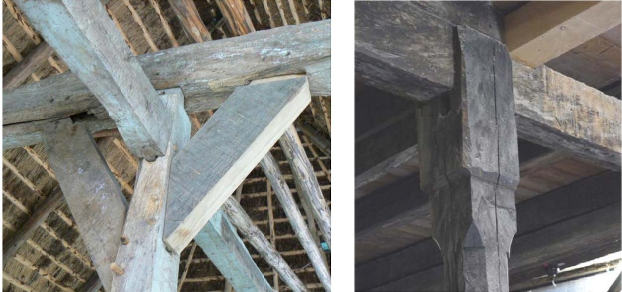
Abbildung 3: Links: schräge Zapfenverbindungen in einer Scheune (Freilichtmuseum Kiekeberg, Deutschland), rechts: Einhalsung des Längsbalkens (Alte Hof in München, Deutschland).
