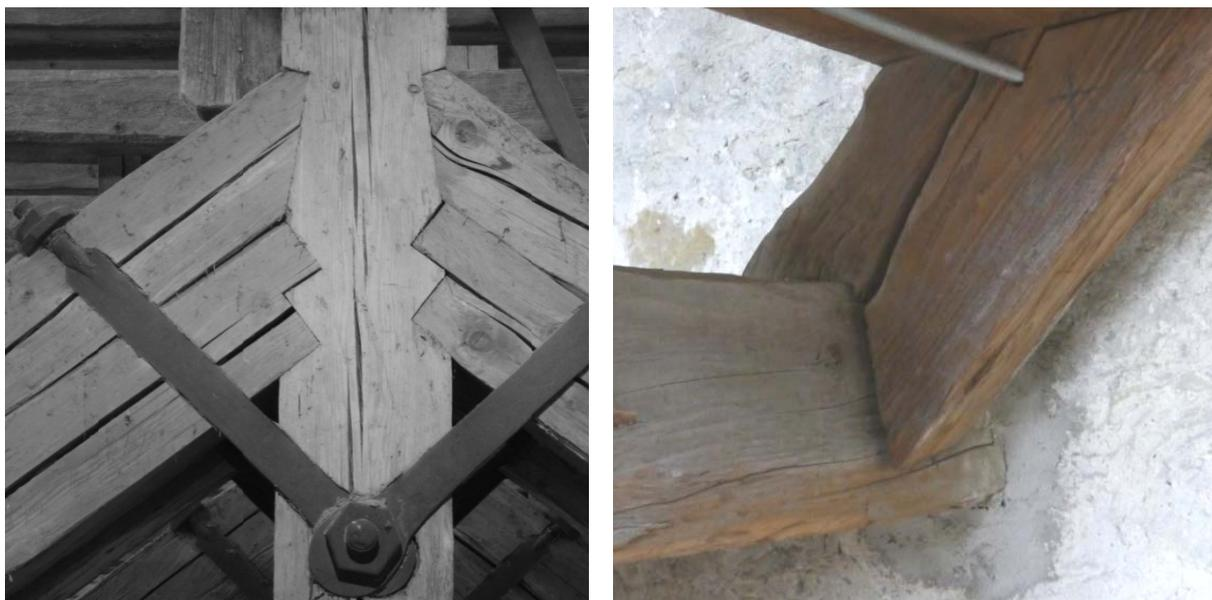
Abbildung 4: Links: mehrfache Versätze an einer Hängesäule (Liebfrauenmünster in Ingolstadt, Deutschland), rechts: Klaue an einer Treppenwange (Wehrmauer von Luzern, Schweiz).
