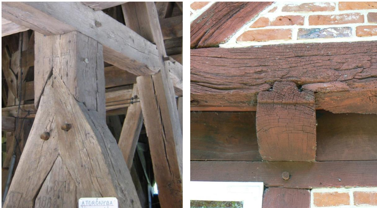
Abbildung 2: Links: einseitige Schwalbenschwanz-Querblätter (Glockenturm von Nyírbátor, Ungarn), rechts: Schwalbenschwanzkamm an einem Fachwerkhaus (Freilichtmuseum Kiekeberg, Deutschland).
