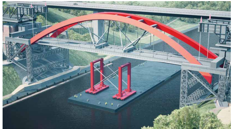
15 Visualisierung der Montage des neuen Überbaus © Ingenieurgemeinschaft Erste Hochbrücke Levensau/Blunck & Morgen Architekten
