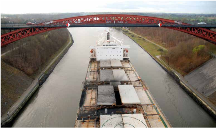
3 Erste Levensauer Hochbrücke aus Sicht der Schifffahrt © Wasserstraßenneubauamt Nord-Ostsee-Kanal/Carsten Bernot
