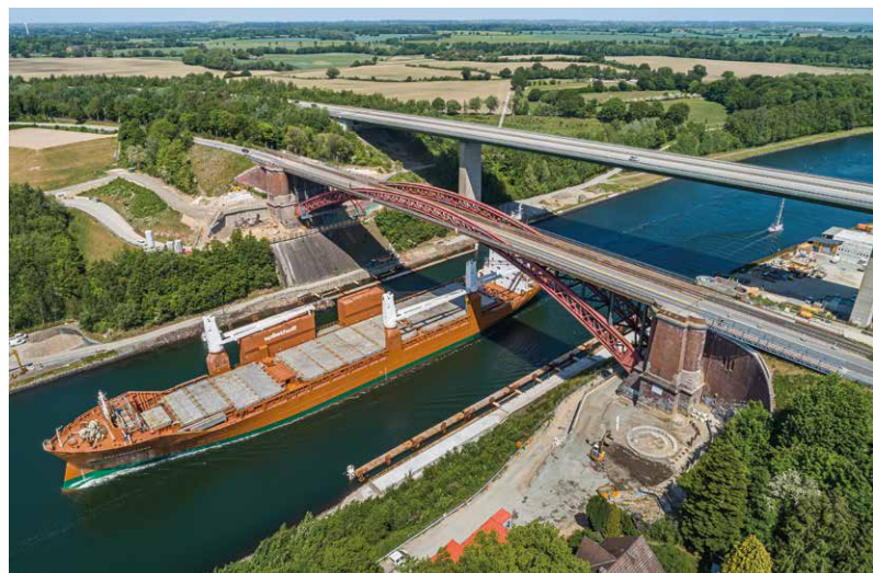
2 Levensauer Hochbrücken im Juni 2023 © Wasserstraßenneubauamt Nord-Ostsee-Kanal/Carsten Bernot
