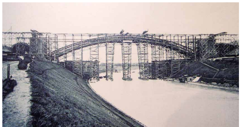
6 Herstellung der ersten Hochbrücke Levensau auf einem Lehrgerüst aus Holz © Wasserstraßenneubauamt Nord-Ostsee-Kanal
